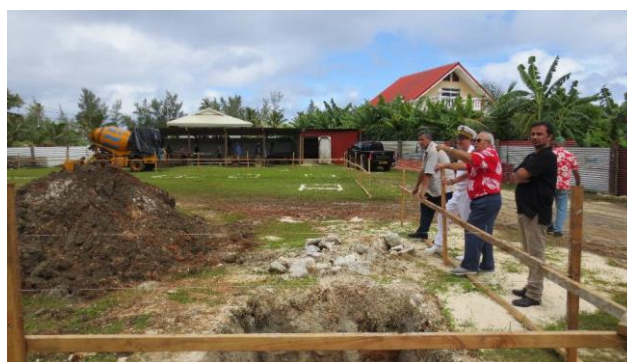
Visite du chantier de la future salle omnisports de Hauti
